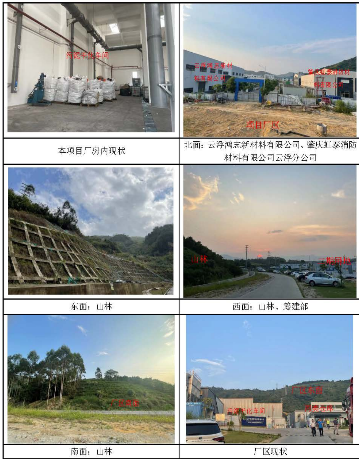
图 4.1-2 项目厂区及四至现状照片
