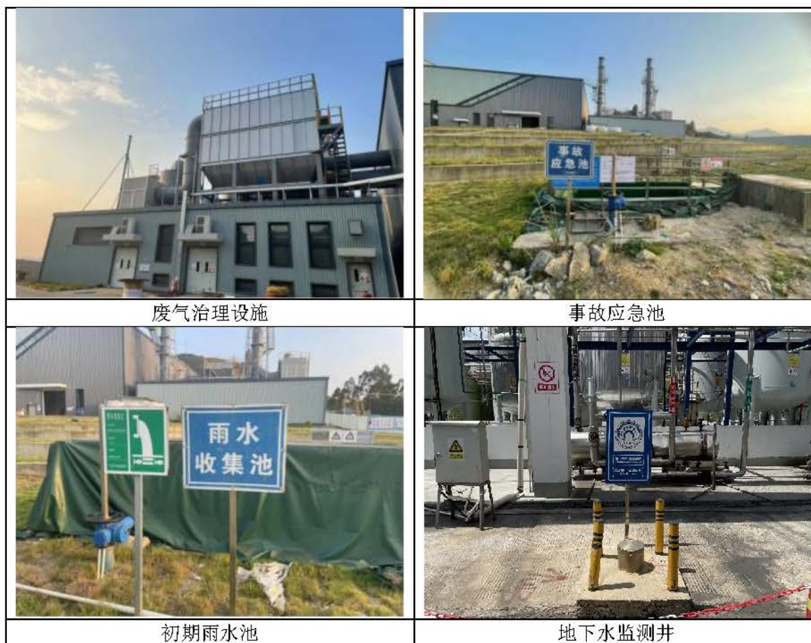
图 3.2-3 现有项目厂区部分设施现场照片
