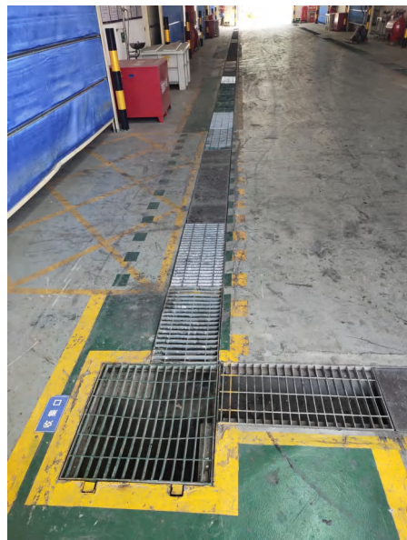
丙类仓库收集渠
