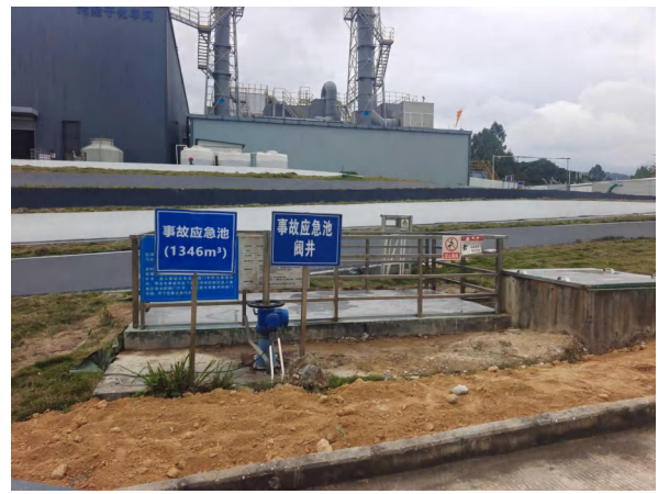
事故应急池（厂区北侧）
