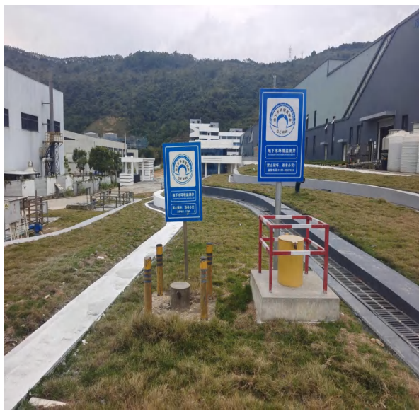
地下水监测井
