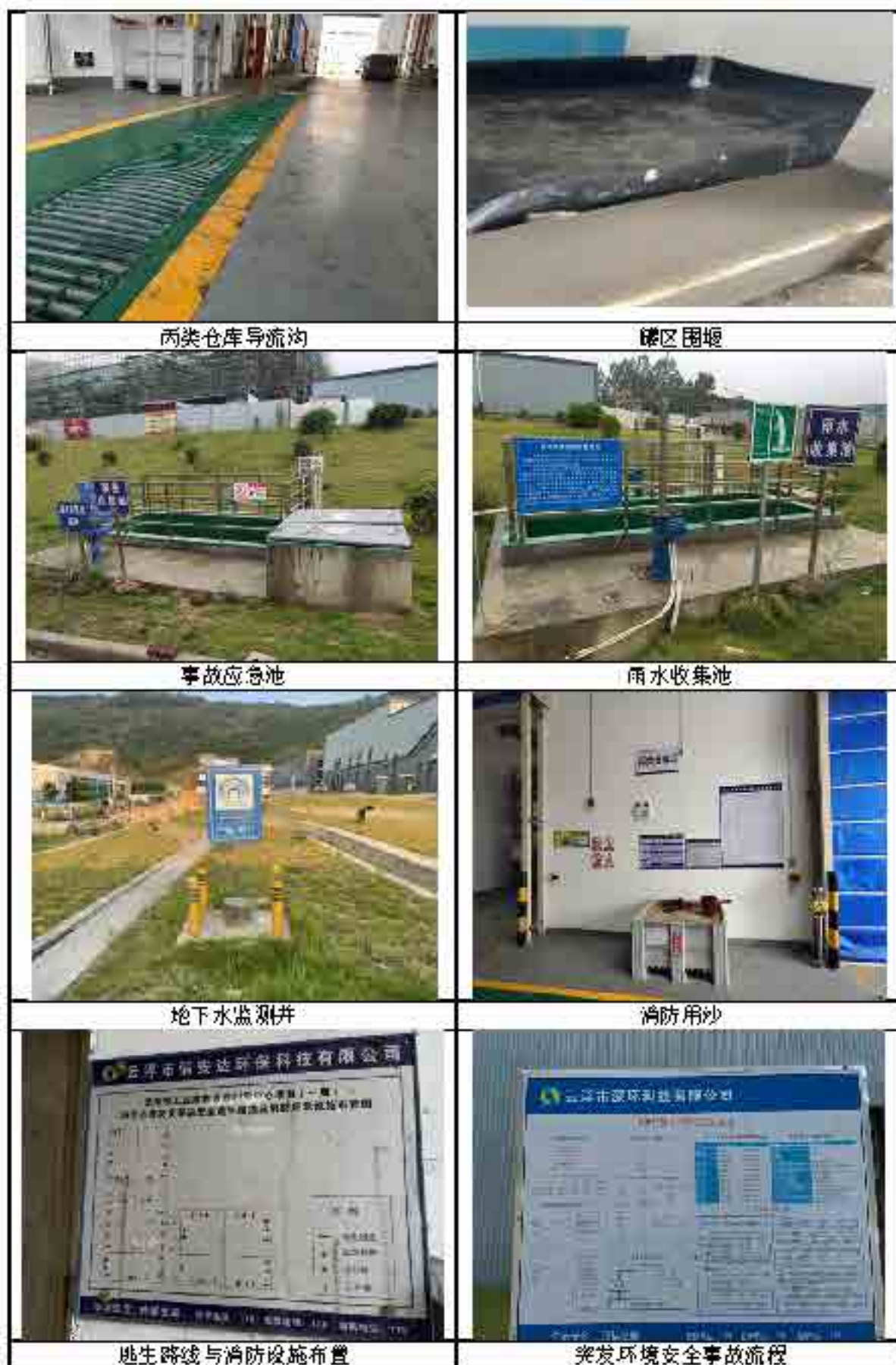
图 7.1-1 厂区内部分设施现场照片
