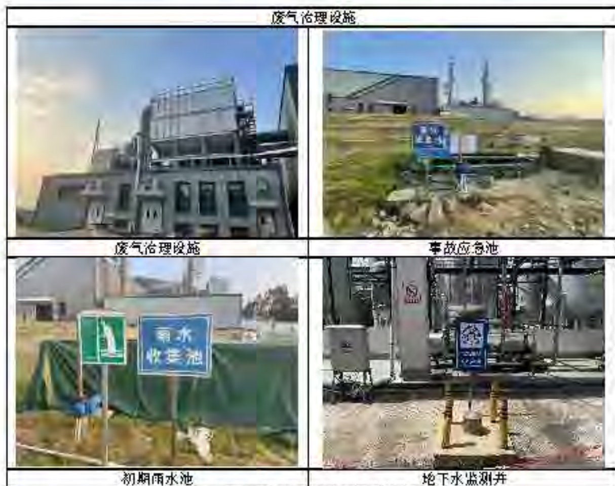
图 3.2-3 现有项目厂区部分设施现场照片
